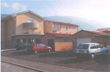
a. collectif et garages des maisons
