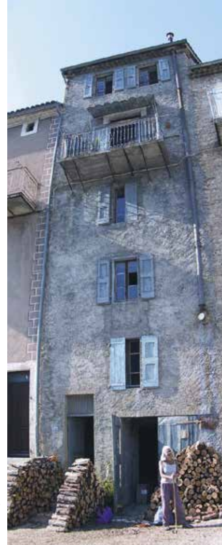
> Maison de rue Valdrôme
