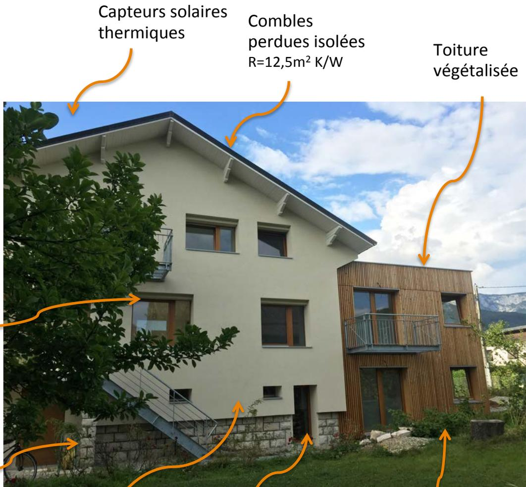
Capteurs solaires thermiques
