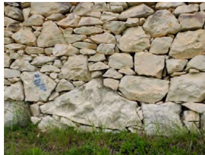
Mur de pierre sèche à La Paillette
