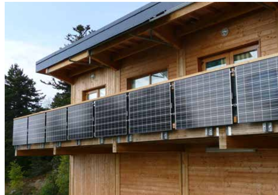
salle des fêtes de Portes-en-Valdaine
