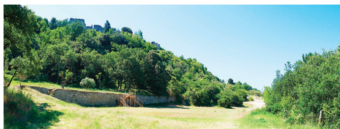
▲ L'entrée de site (vue sur le Vieil Allan en surplomb)
