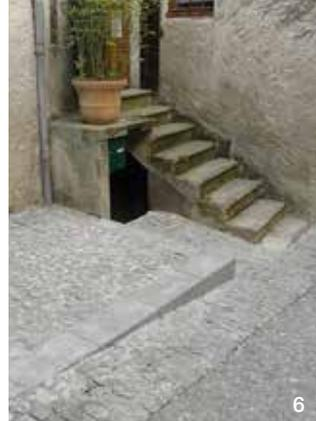
▲ Châtillon-en-Diois : traitements perméables des pieds de façades : végétation ou pavés calcaires sur béton de chaux
