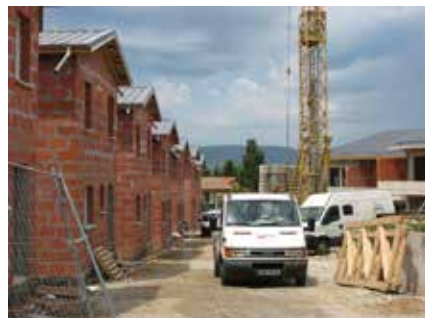
En chantier : les villas en accession
