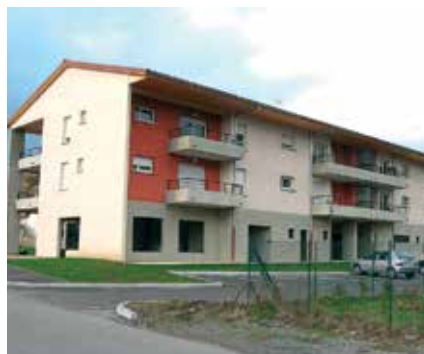
L'immeuble DAH façade sud.
