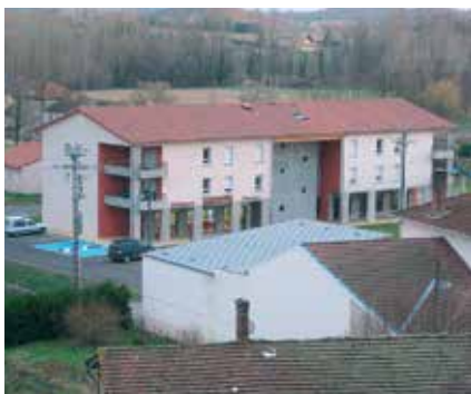
L'immeuble DAH vu depuis la montée au plateau.
