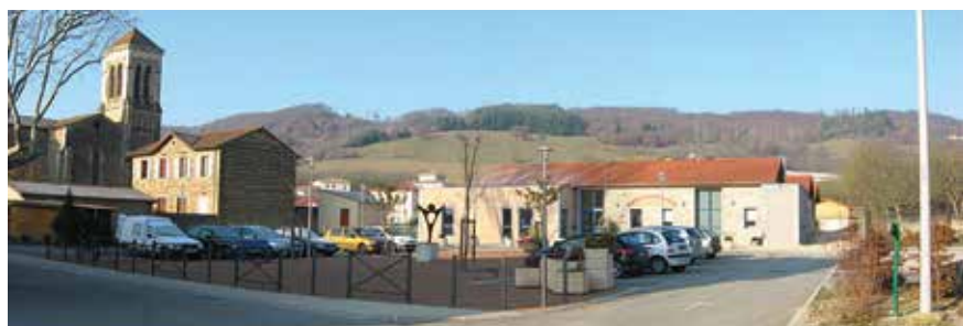
Mairie, nouvelle école et chaufferie bois
