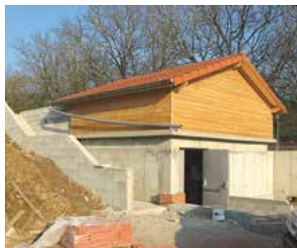
La chaufferie bois en construction
