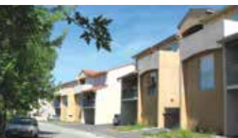
De l'habitat intermédiaire (en accession) sur le coteau
