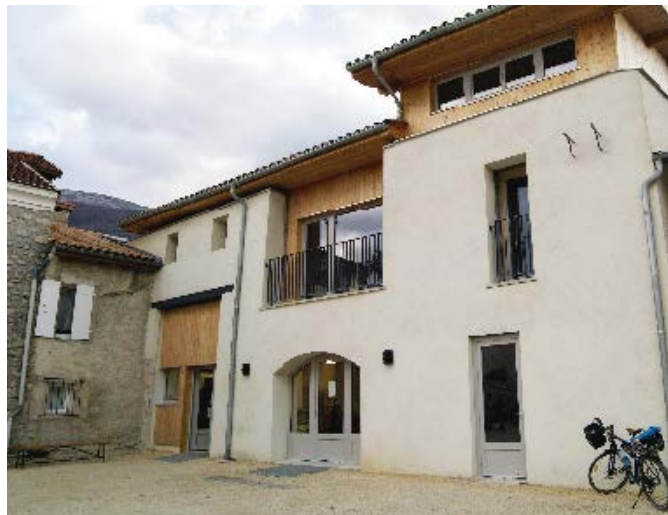
▲ La façade principale : avant et après rénovation
